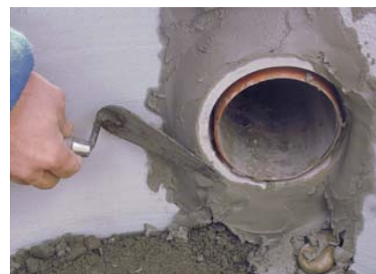
Osadzenie przejścia rurowego za pomocą PCI Polyfix® plus.
