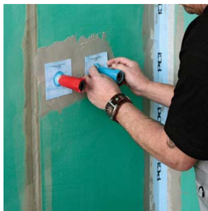
Wklejenie manszet PCI Pecitape® 10 x 10 na warstwie izolacji PCI Lastogum® szary.
