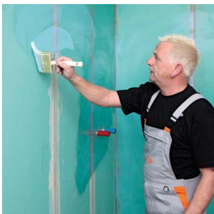
Gruntowanie nierozcieńczonym środkiem PCI Gisogrund®.
