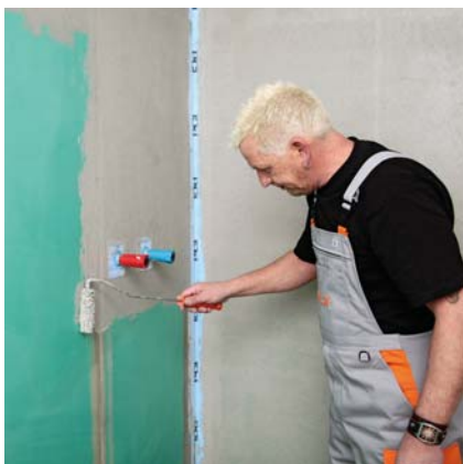
Nałożenie (z pełnym pokryciem podłoża) warstwy izolacji PCI Lastogum® szary na pozostałej powierzchni z jednoczesnym przesmarowaniem brzegów taśm i manszet.
