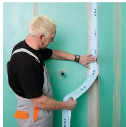
Wklejenie taśm PCI Pecitape® Objekt na warstwie izolacji PCI Lastogum® szary.
