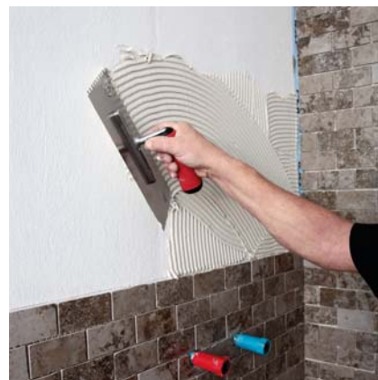
Wyklejenie okładziny płytkowej na odpowiedniej elastycznej zaprawie klejącej PCI.
